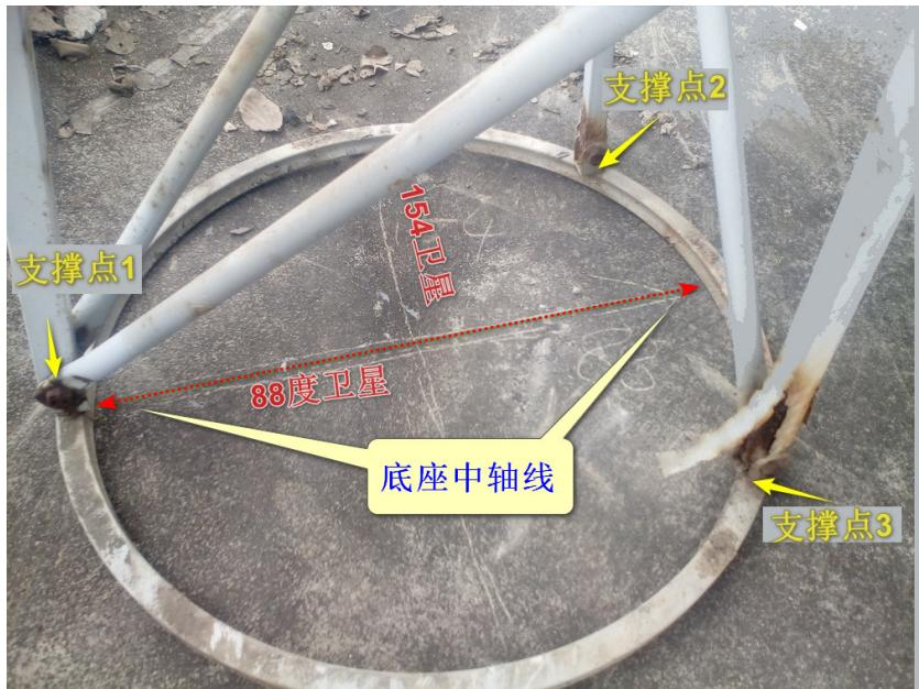
**第二步：**向左旋转90-100度左右（可以查《全国卫星天线仰角、方位角、极化角数据库》计算各地准确值）。
